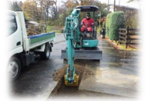
土木・舗装工事
