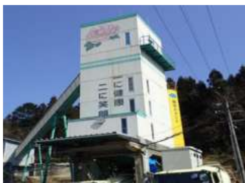
生コンプラント工場
