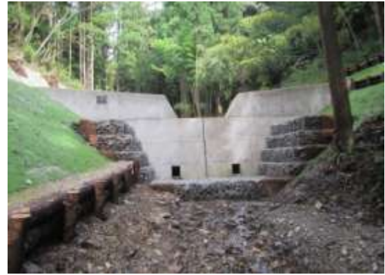
施工実績：溪間工事
