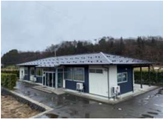
正木建設 本社建物
