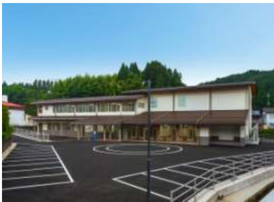
施工実績：みんなの広場 来島交流センター
