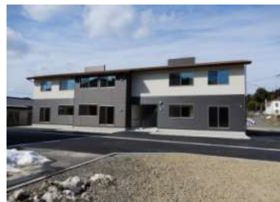
施工実績：新衣掛団地
