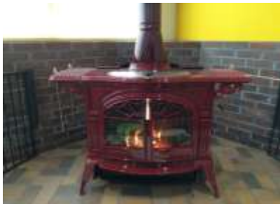
飯南町庁舎へ薪ストーブ設置
