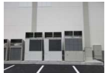
来島複合施設へガス空調設備設置
