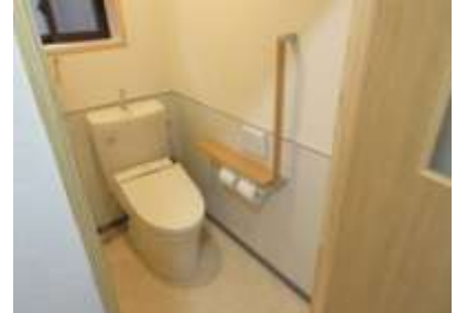
リフォーム工事（節水型トイレ）
