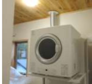
ガス衣類乾燥機取付
